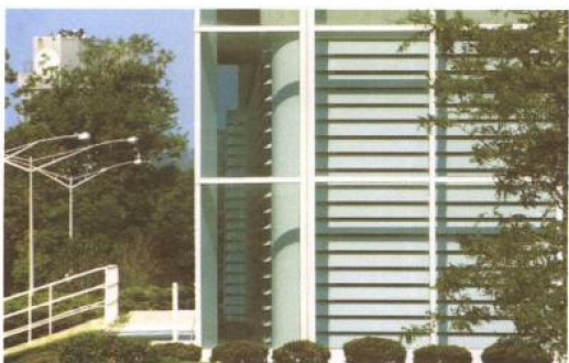
▲ 由佳能公司设计,位于纽约州尼亚加拉大瀑布的西方化工大楼建于1981年,原名Hooker大楼。它是第一批把智能因素融入建筑外层设计的大楼之一。巨大的翼形太阳能保护隔栅自动倾斜防止阳光直射到内部玻璃墙面。这个过程通过每侧隔栅后部边缘的太阳能电池完成
