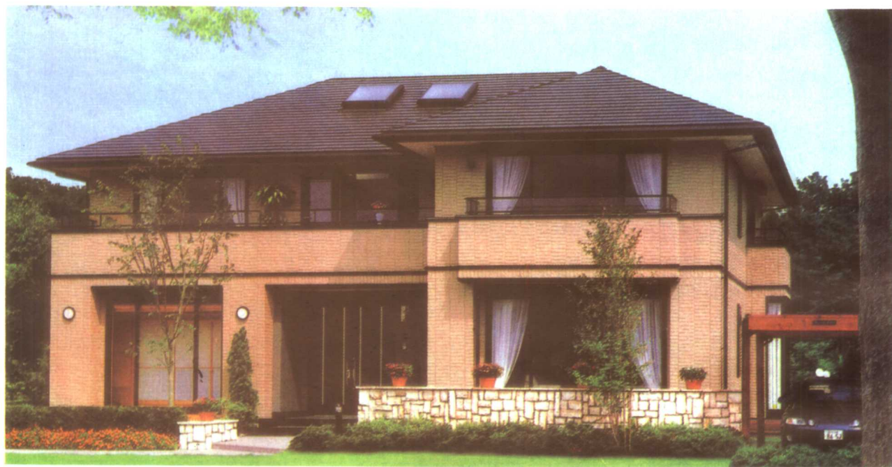
▲图 1—17 落地玻璃窗有效地利用了自然光，使室内开敞明亮，又使空间内外交融、自然过渡
