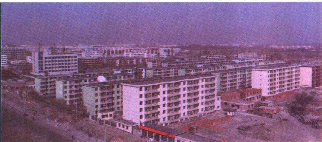
临河里小区住宅楼
