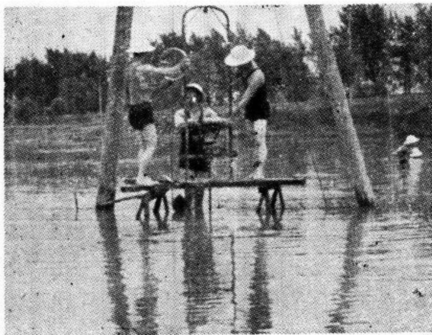
图 1—3 武汉电业工人用取样钻在水中施工情景
