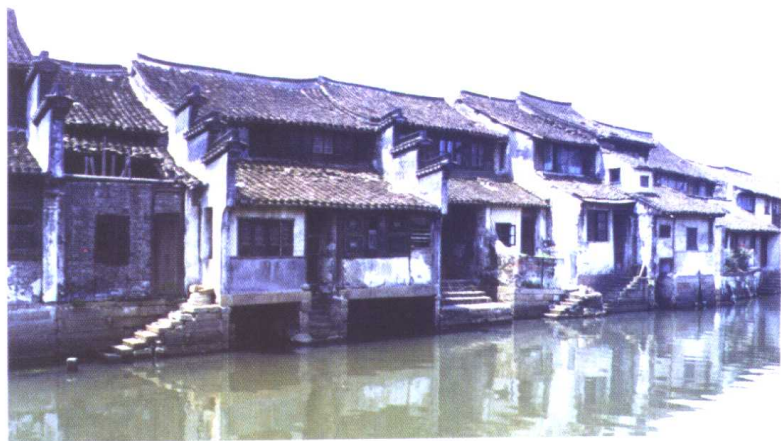
西塘沿河民居建筑
