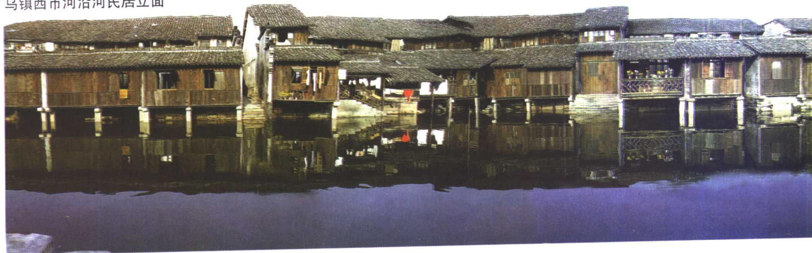
乌镇西市河沿河民居立面
