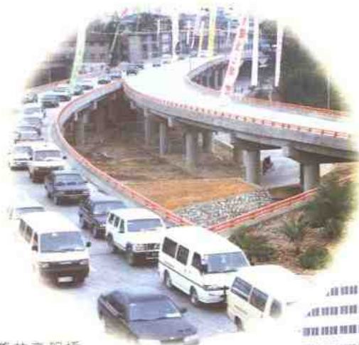
该公司设计的鹤林高架桥
