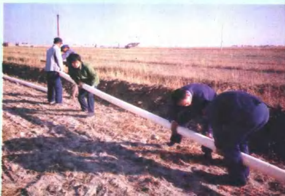
按装灌溉地下防渗管道
