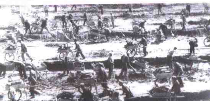
开挖大广安干渠
