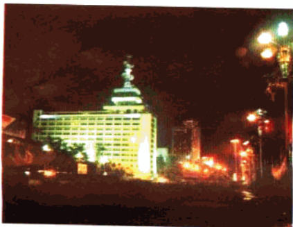
18. 柳州市电信大楼
