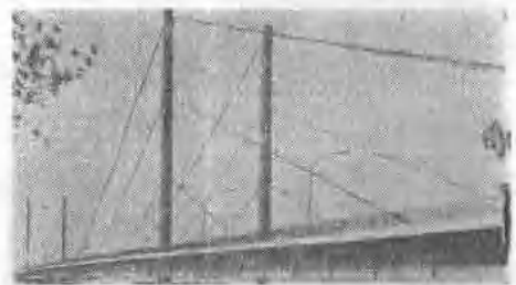
杜塞尔多夫北桥(1953年)
