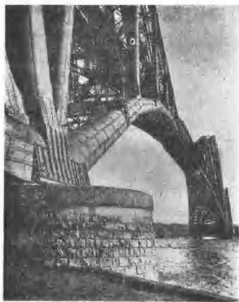
苏格兰的福斯湾铁桁桥（1890年）
