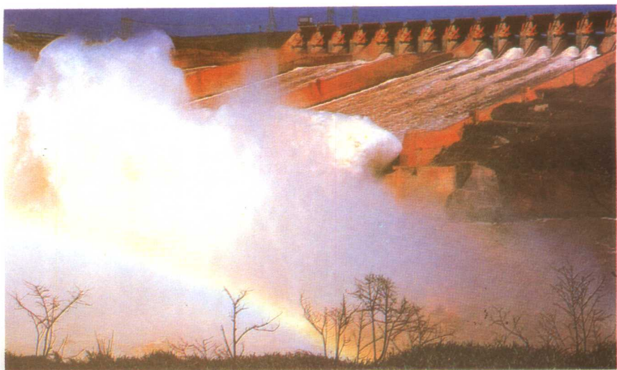
▲ 伊泰普水电站是世界上最大的水电站，其大坝有60层楼高，坝后的水库沿河延伸达161千米，大坝横亘在巴拉那河上。该河构成了巴西与巴拉圭两国边界的一部分。
