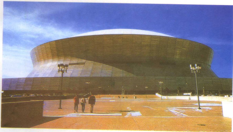
▲ 世界上最大的室内体育场——美国路易斯安那圆顶体育馆。世界上有史以来最大的圆顶，盖住了整个体育场。圆顶直径达210米，体育场占地总面积为21万平方米。一次可容纳76 791人观看比赛，圆顶下面的6块特大型电视屏幕可同步播放比赛实况。
