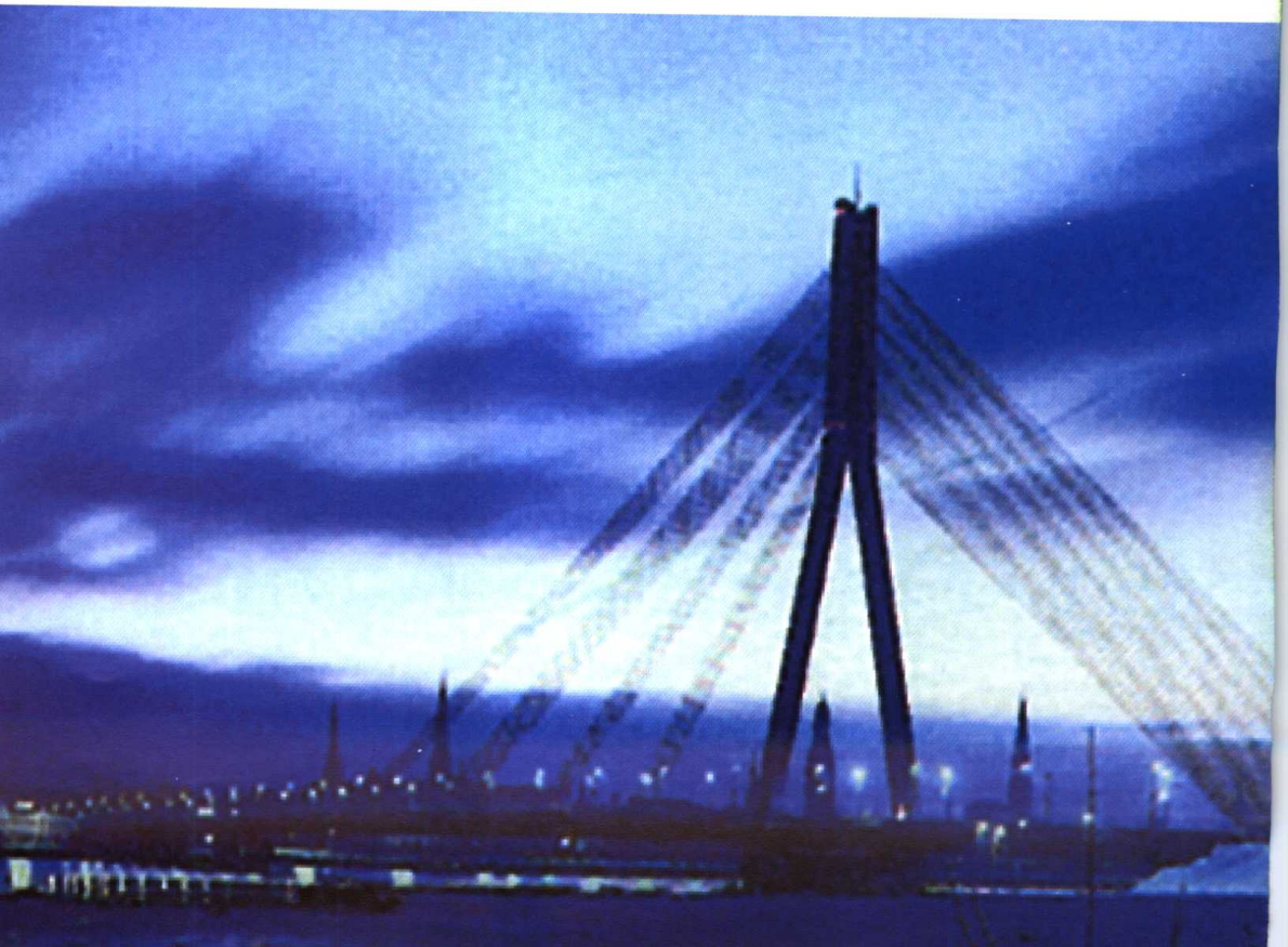
里加道加瓦河斜拉桥
