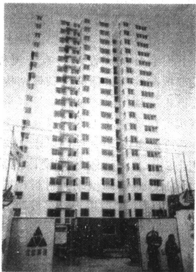
图 1-5 上海园南四街坊 18 层住宅
