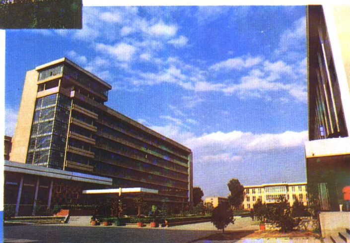
◀唐山工程技术学院综合教学楼
