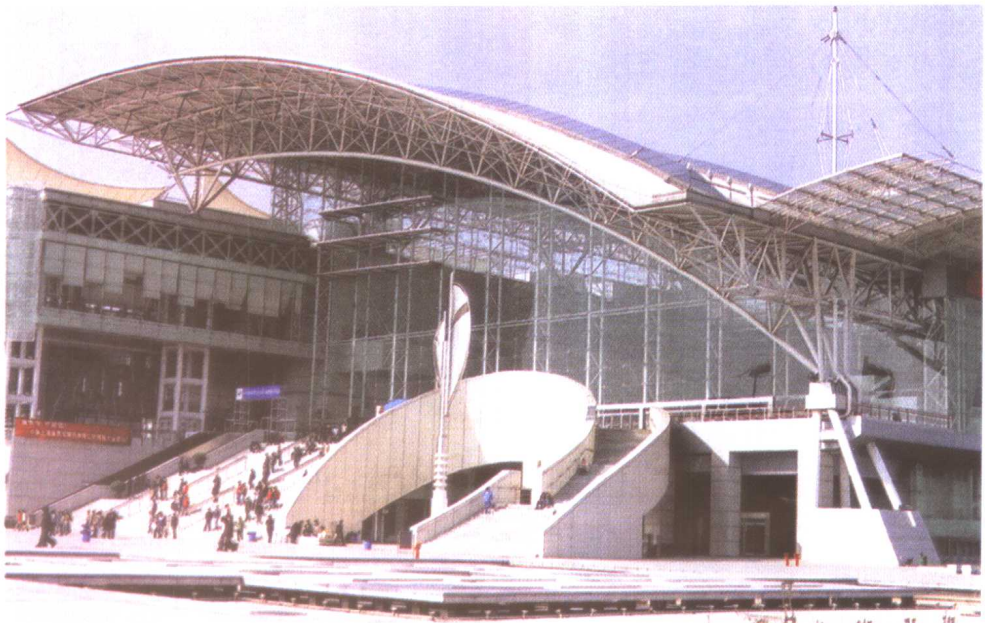
点支式玻璃幕墙外观
