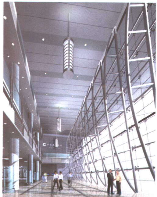
点支式玻璃幕墙局部(二)
