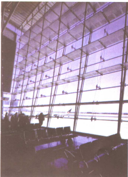
点支式玻璃幕墙局部(一)
