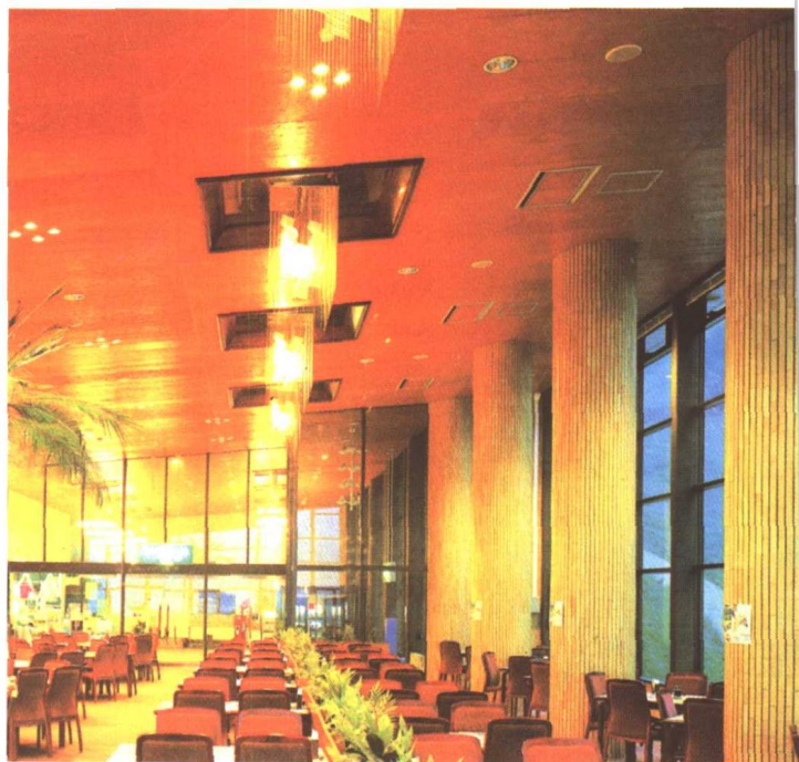
彩图 1 平面式木吊顶，木条拼接式装饰柱
