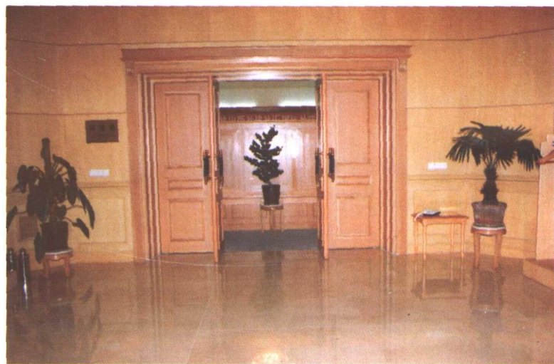
彩图 12 木板式墙板、嵌板式木门、木门套板
