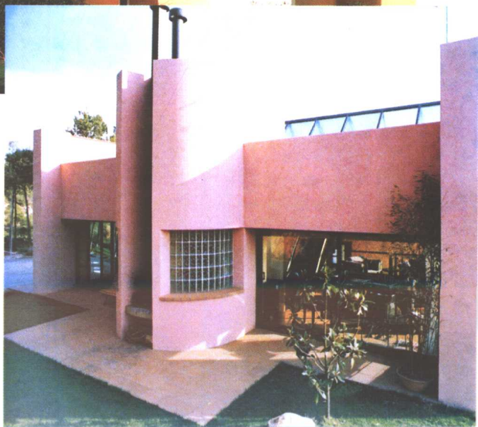
彩图 2 外墙涂 料工程
