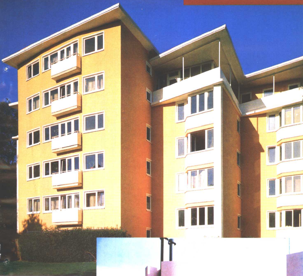
彩图 1 住宅工 程外墙涂饰
