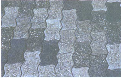
混凝土块铺装 (锁结式铺装)
