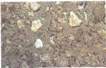
沥青半刚性铺装
