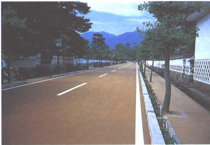
彩色沥青铺装
