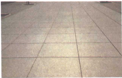
水磨石板铺装 (现浇, 经混凝土切缝机切缝后完成)
