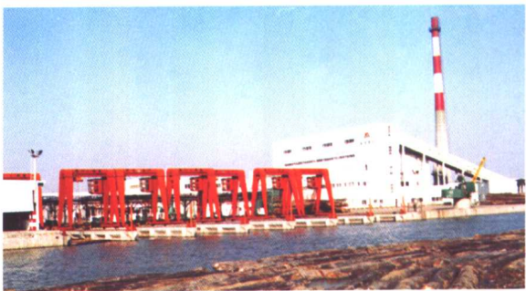
上海新高潮(集团)下属发电厂
