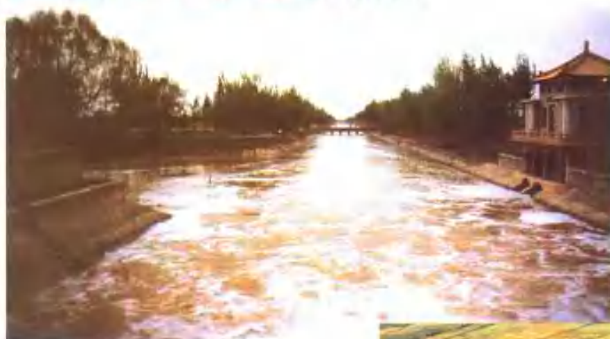
▲ 人民胜利渠一号跌水工程
