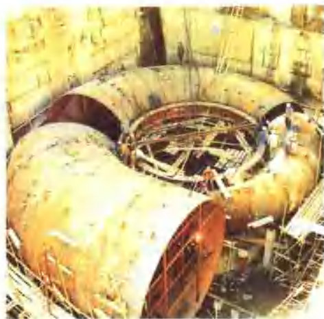
▲ 潘家口水电站15万千瓦常规发电机组蜗壳的安装情景
