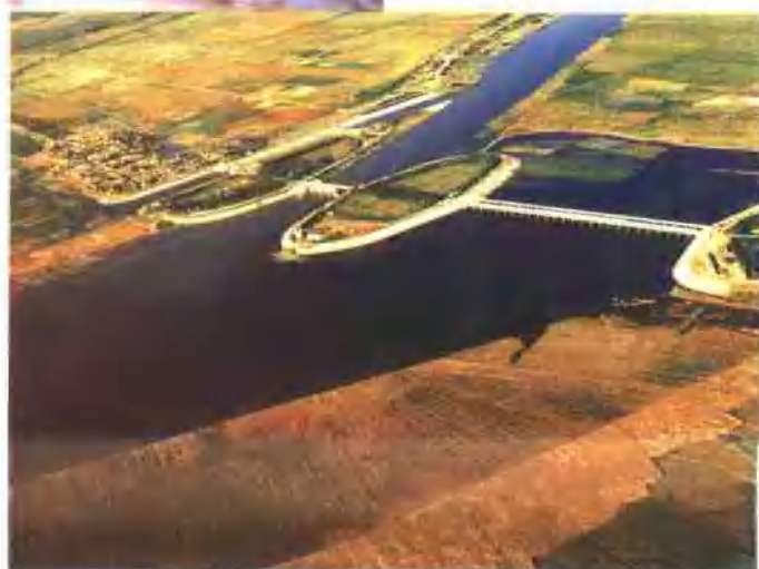
枣林庄水利枢纽工程 ▶
