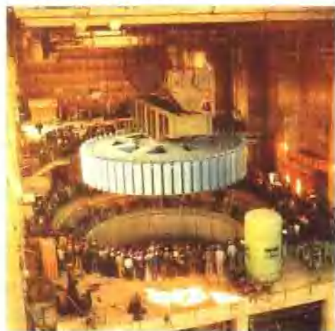
▲ 潘家口水电站常规机组第一片发电机转子的吊装情景
