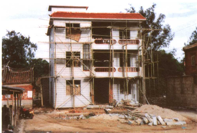
即将完工的埕边村敬老会新楼
