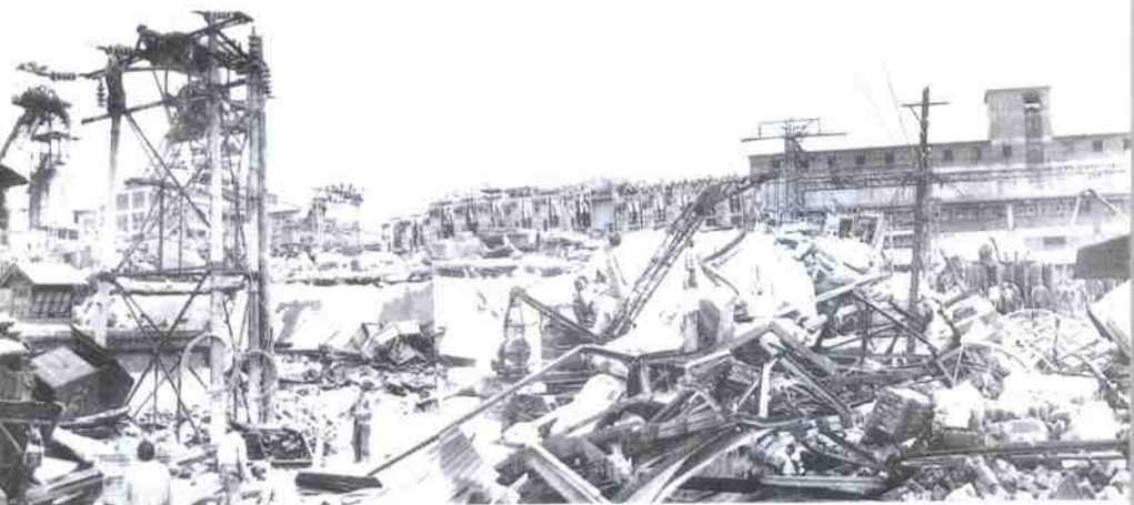
地震破坏的矿区变电站
