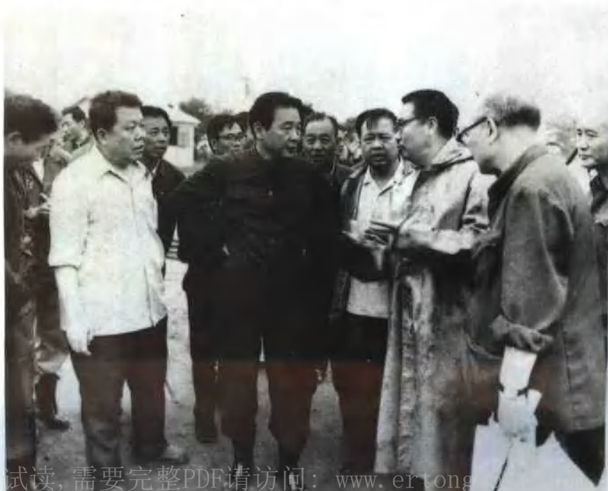
1984年6月15日，国务院副总理李鹏冒雨视察开滦范吕透水工地
