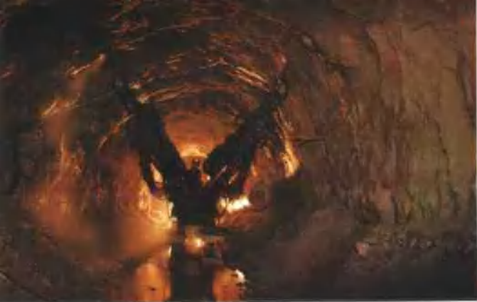
使用液压钻车 进行巷道开拓
