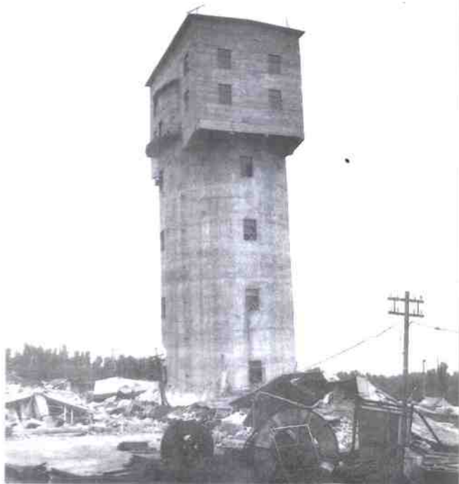
唐山矿风井 绞车房被震 坏倾斜
