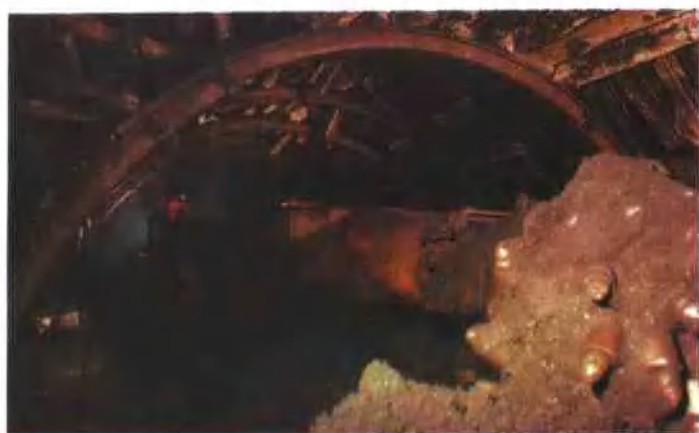
使用综合掘 进机掘进
