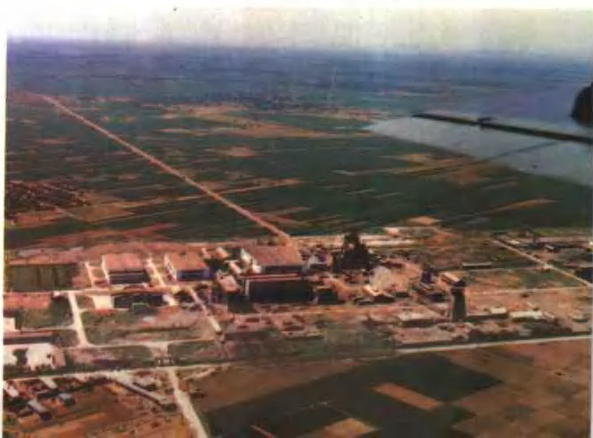
正在建设中的年设计能力为 300 万吨的东欢坨矿
