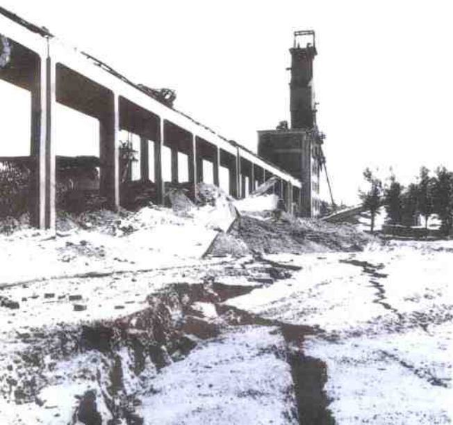
范各庄矿井口附近 的地裂状况
