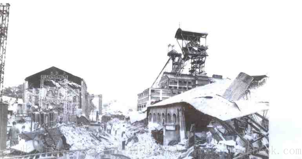
地震破坏的唐山矿三号井
