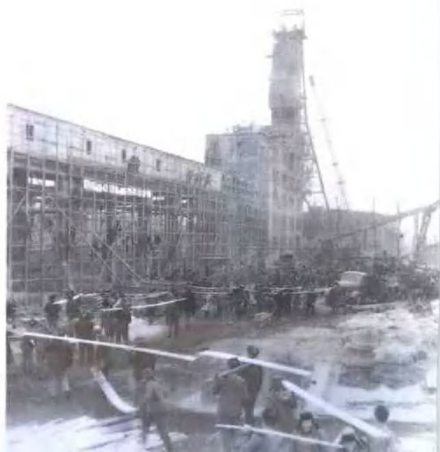
震后恢复建设
