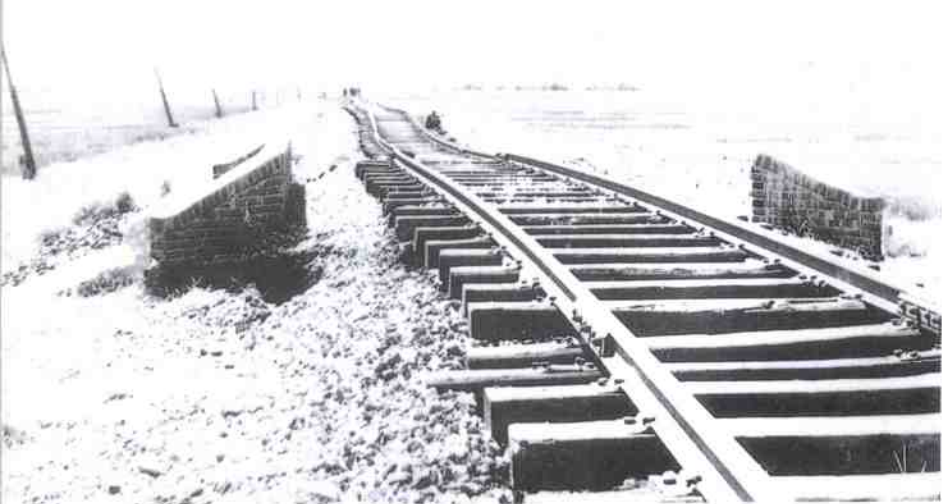
地震扭曲的矿区吕范铁路
