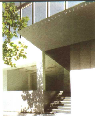
公司办公楼入口 Office entry
