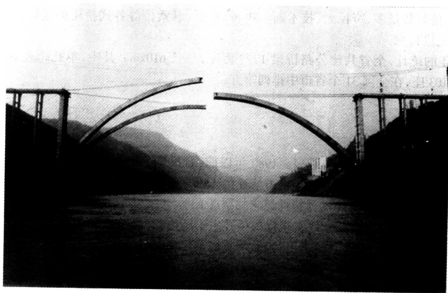
图2 涪陵乌江大桥同步转体
