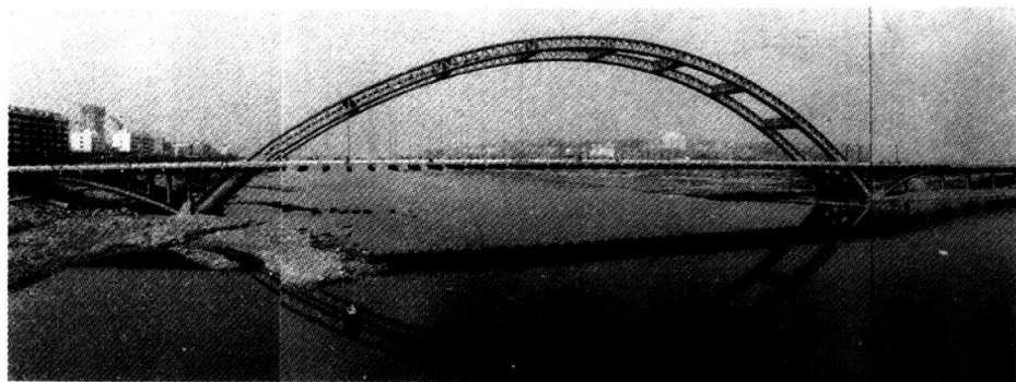
图5 绵阳涪江三桥全貌
