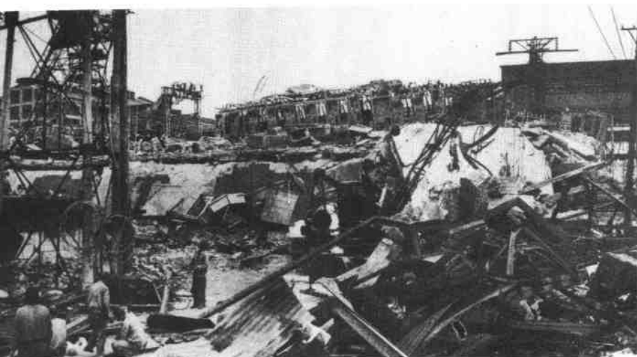
震毁的矿山变电站情景。
