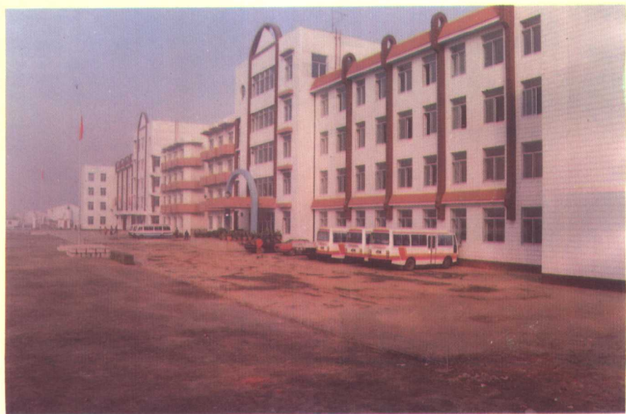
沈阳市私立博文学校教学楼全景
