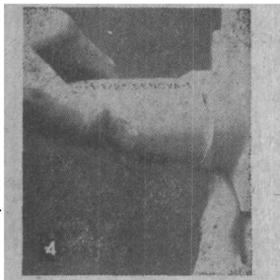
4. 配装好的接头周围有一圈边胶边,表明溶剂胶够了,接头牢固了。为了取得最好的效果,先在管端、后在管接头上涂上胶料,再在管端涂上溶剂胶。这样,多余的溶剂胶就会从焊接处挤出,而不会挤入管内或管接头里,障碍水流。溶剂胶涂上后,要尽快把管子、接头接合。接头压入后,稍稍旋转一下,既可对齐,又可使溶剂厚薄均匀。捏住二、三十秒钟
