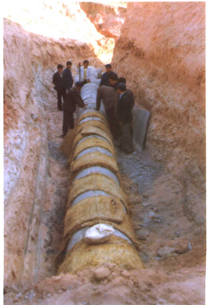
治沟骨干坝工程放水涵管
