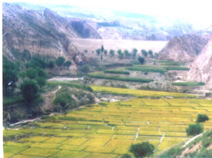
山西省离石市磨湾治沟骨干坝工程
