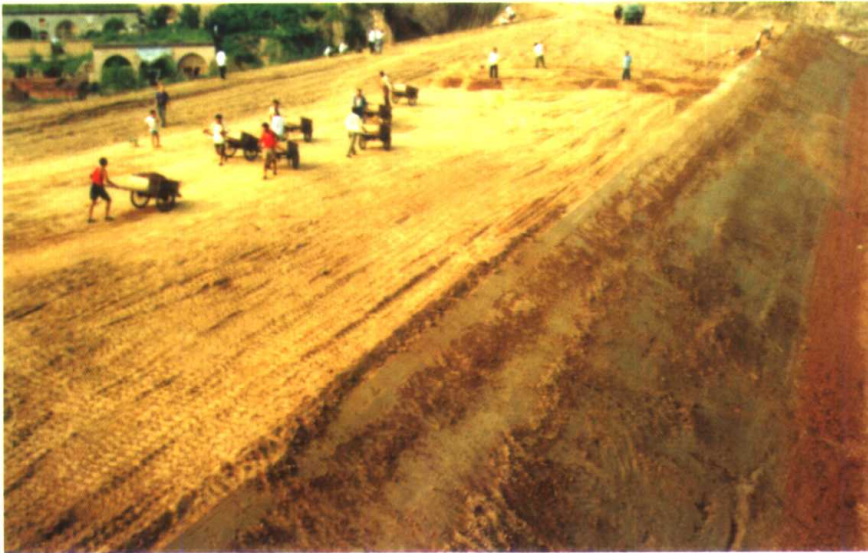
治沟骨干坝工程坝体碾压施工
