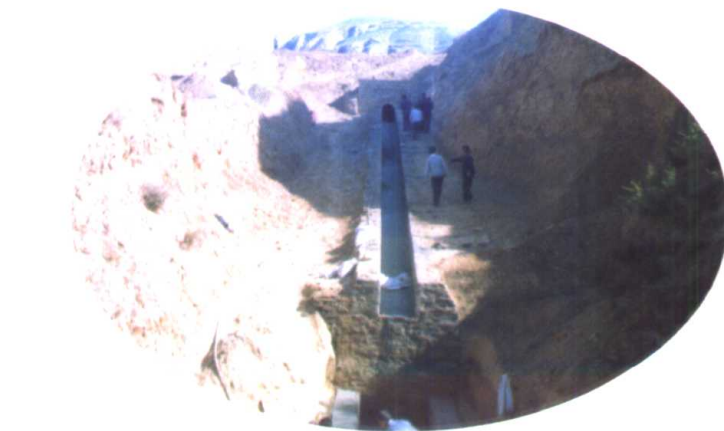
治沟骨干坝工程泄水明渠
