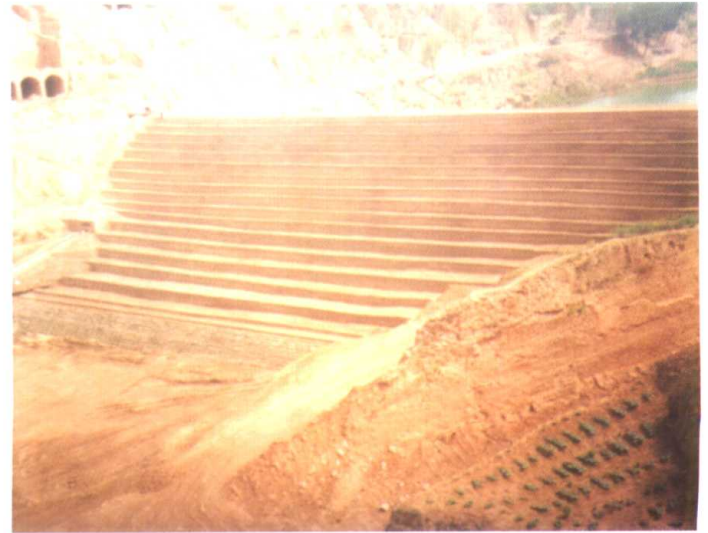
陕西省志丹县黄沟门治沟骨干坝工程
