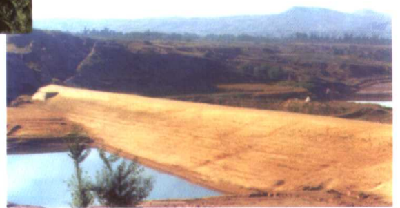
内蒙古自治区伊金霍洛旗 特拉沟治沟骨干坝工程
