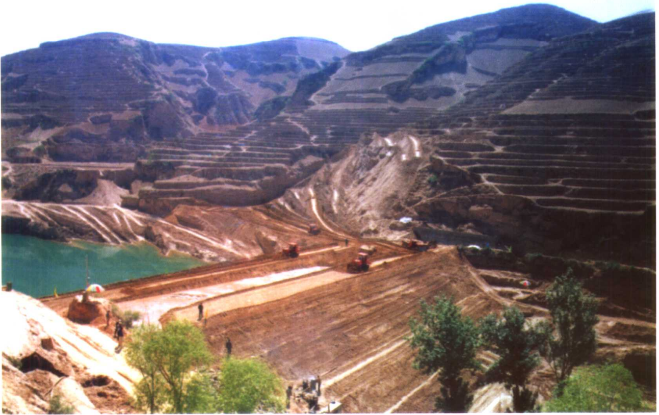
治沟骨干坝工程水坠施工边埂碾压
