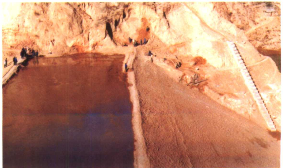
治沟骨干坝工程坝体水坠施工
