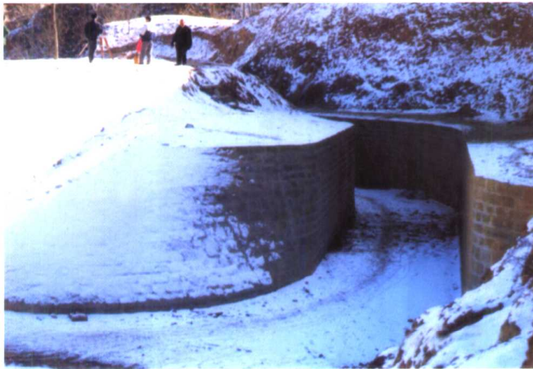
治沟骨干坝工程溢洪道
