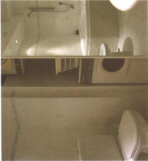
一。热的毛巾杆可以提供少量的热量，但几乎全被毛巾吸收了。暖气管和毛巾杆共同使用可起到加温的效果，还可以在施工时在地板下设加热器。要注意夏天当加热器关闭时，毛巾杆也不再散热了。在此建议，即使天气较热，有一个暖烘烘的干燥的毛巾也是好的。这样可将它与热水系统相连或用电来代替。
