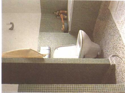
如有可能，在浴室设计中应使地板的高程做些变化（见上图）。淋浴区的地面就比较低，再加上一个堵分隔墙，这样就使大部分水不会外流，也不影响浴室其他空间的使用。整个浴室的地板一直铺到墙裙高度，并与瓷砖连成一体可以阻止水的渗入，马桶和脸盆都挂在墙上，这样地表面很容易清洗。浴缸和脸盆都采用流线型的新式水龙头，在浴缸的另一头安装一个白色的梯形支架，这样就使空间得到充分利用。
