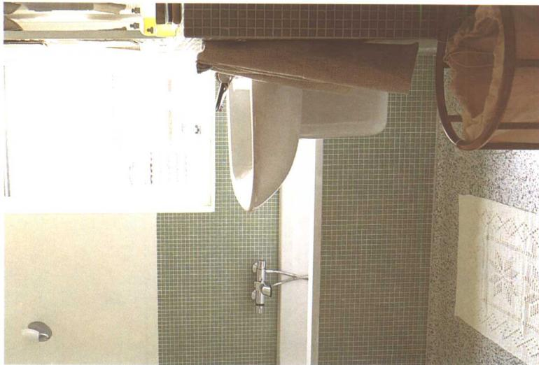
如果浴室的使用对象是儿童，那么选择设备时就要考虑孩子身材比较矮这一因素。举个例子来说，墙挂盆高度要安装合适，要选择低水位水箱的厕所，便于使用，浴缸的边也应较低，底部应平坦且不滑，淋浴器的喷头应可转动。可能的话，应装设热安全控制器防止孩子被烫伤。如果墙上有龙头和混水器的喷嘴应防止碰到孩子的头，而且不能让它们够到。
