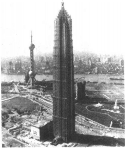
图 1-2 高层钢结构建筑
