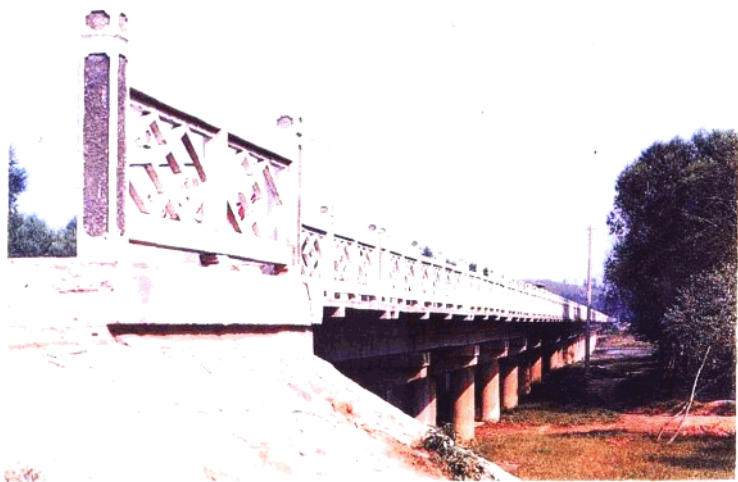
8. 三抚公路建昌营东沙河大桥
