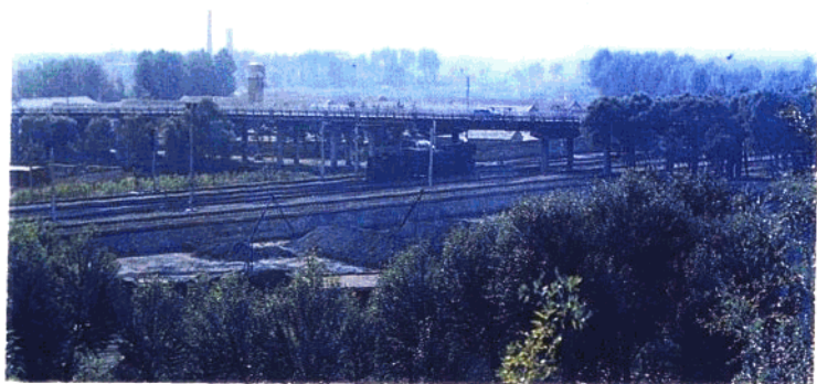
9. 京沈公路沙河驿立交大桥
