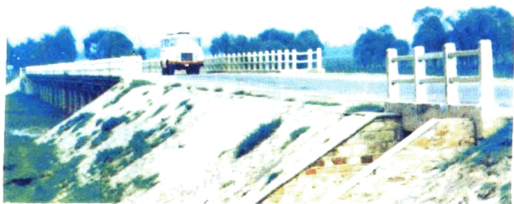
10. 京沈公路沙河驿东沙河大桥
