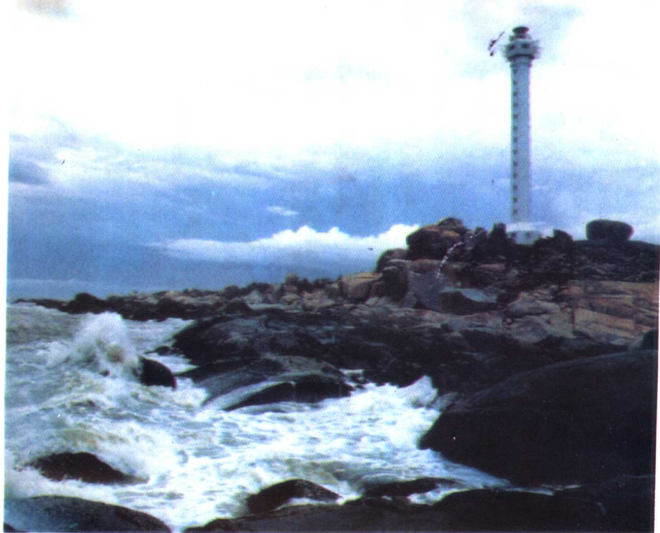
亚洲第一航标塔(位于惠来县靖海镇石碑山)
