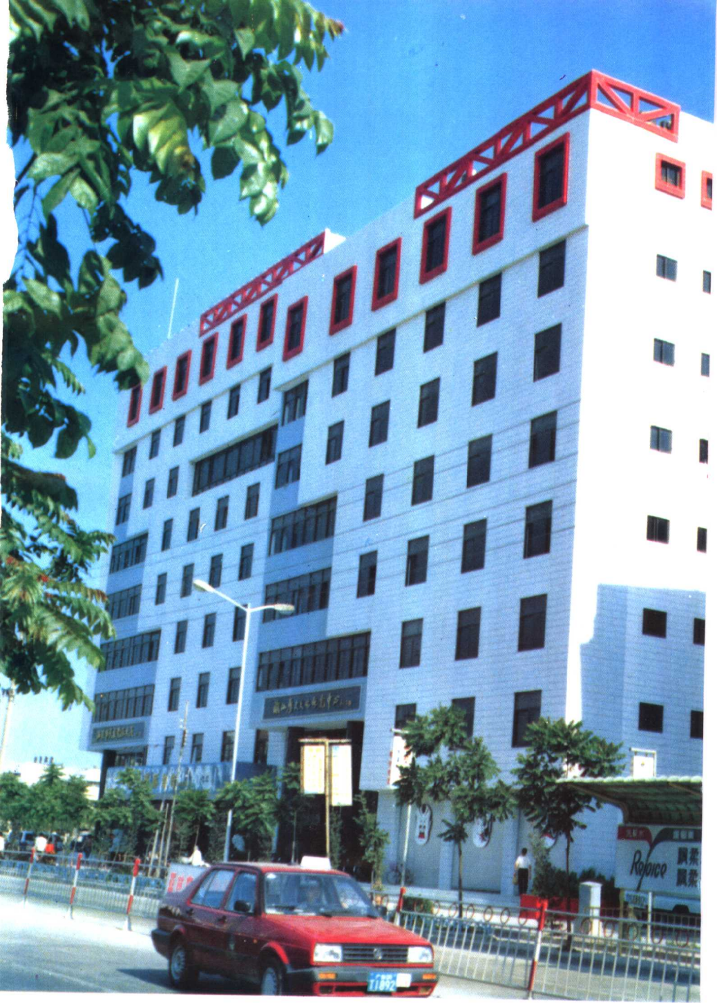
潮汕历史文化研究中心大楼
