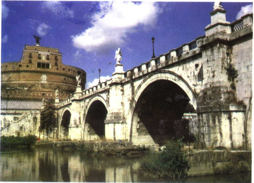
图 2 意大利罗马泰莱柏河的 Saint Angelo 桥
