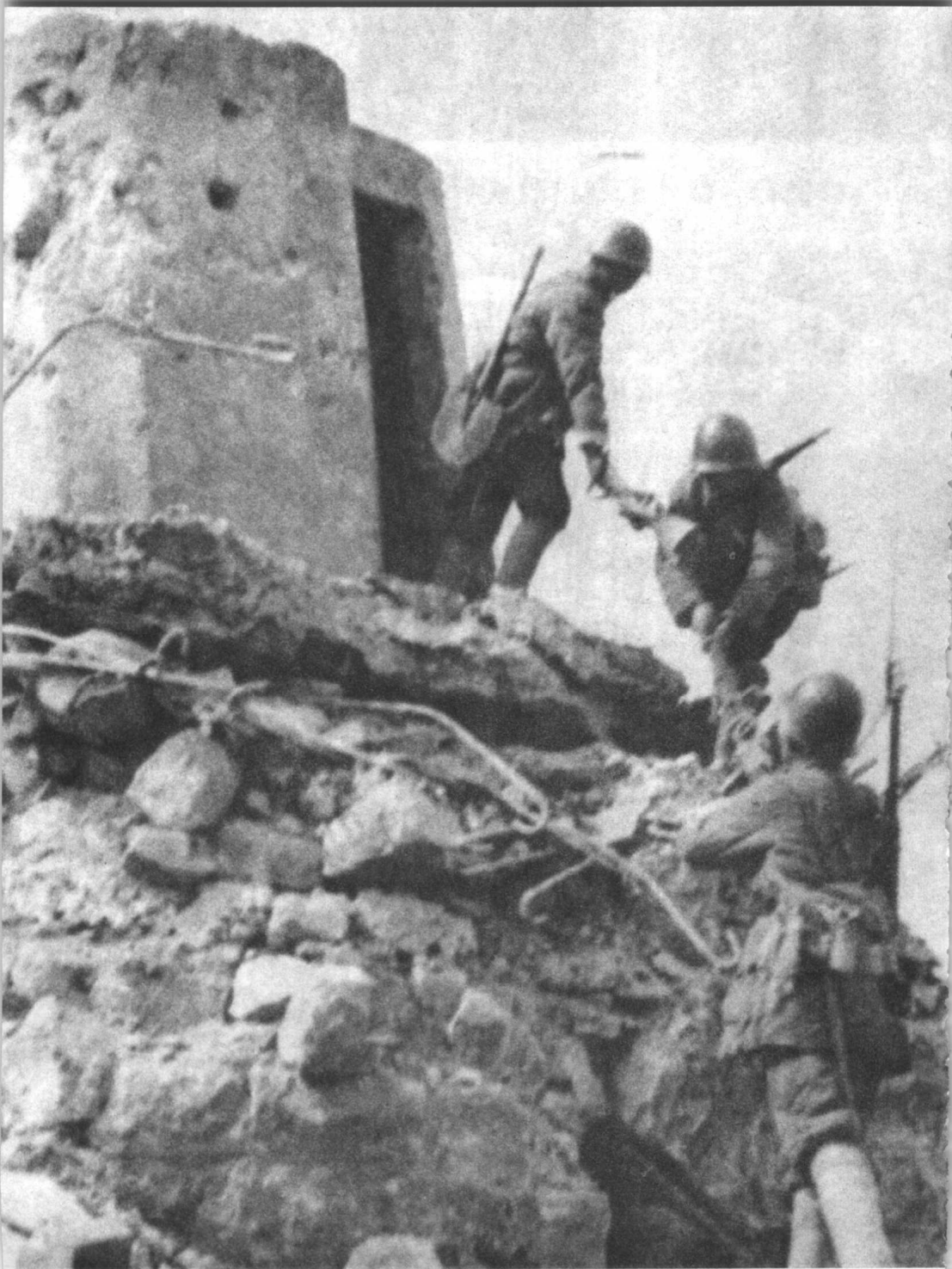
被我军炮火摧毁的敌军钢筋水泥工事
