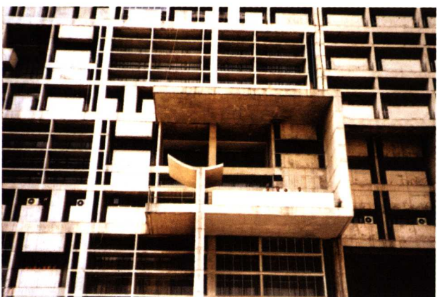
[彩图 44](图 3-60) 昌迪加尔秘书处大楼局部
