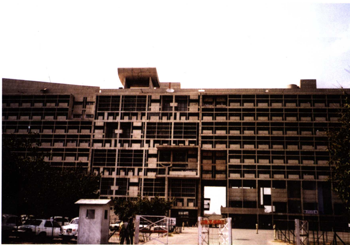
[彩图 46](图 3-58) 昌迪加尔秘书处大楼局部
