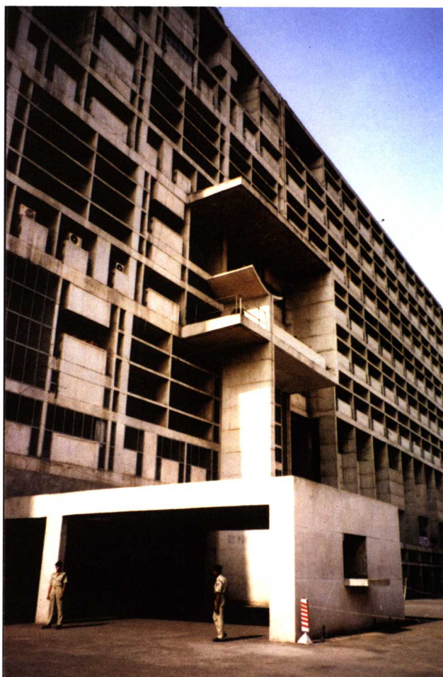
[彩图 45](图 3-59) 昌迪加尔秘书处大楼局部
