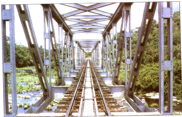
这是用桁架方式兴建的铁路桥，位于尼日利亚西部的伊巴丹附近的奥贡河上。
