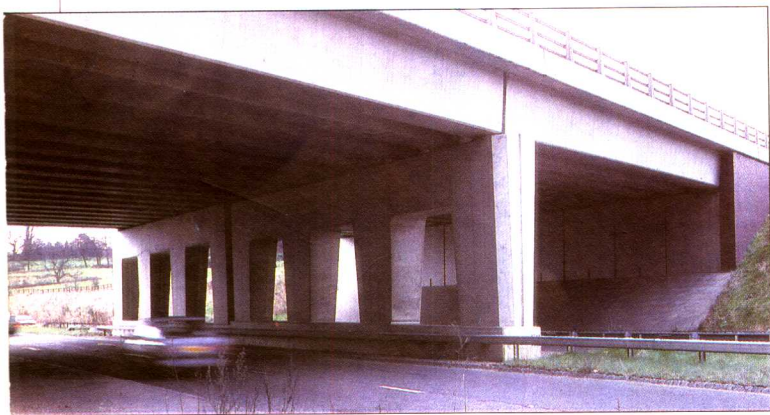
这是典型的混凝土横梁桥,位于伦敦到处可见的高速公路上。
