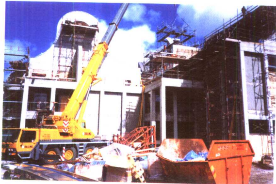
图1-9 建筑工地——环境建设是多学科的融合
