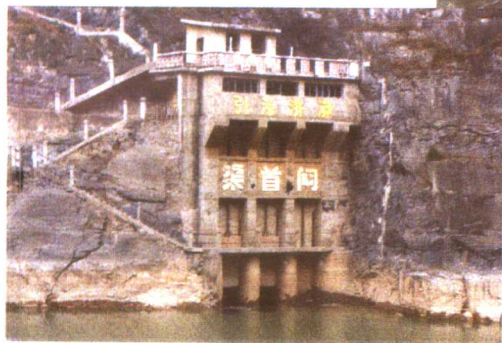
引沁济蟒渠首闸
