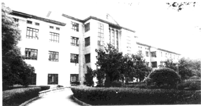
在荒山坡上建起的办公大楼
