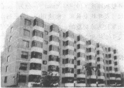
图 2 北京多层砌块房屋 (工程照片由唐岱新教授提供)
