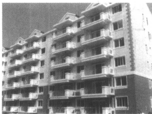
图 5 6 层模卡砌块建筑上海“汇丽苑” (工程照片由顾陆忠院长提供)
