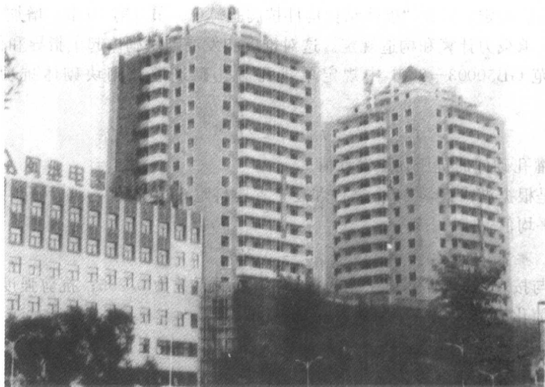
图 6 哈尔滨 18 层砌块夹芯墙高层建筑 （工程照片由唐岱新教授提供）
