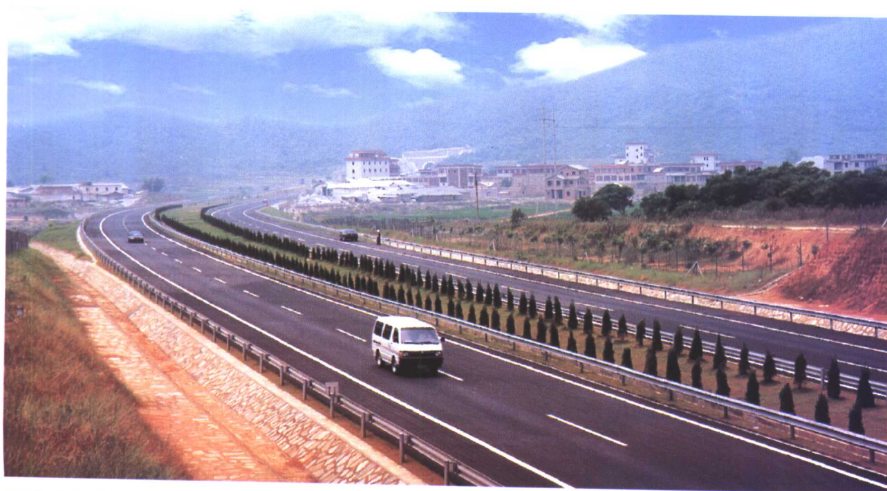
隧道进口路段
