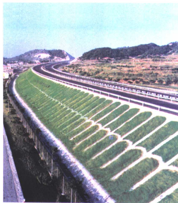
路堤边坡拱型护坡防护
