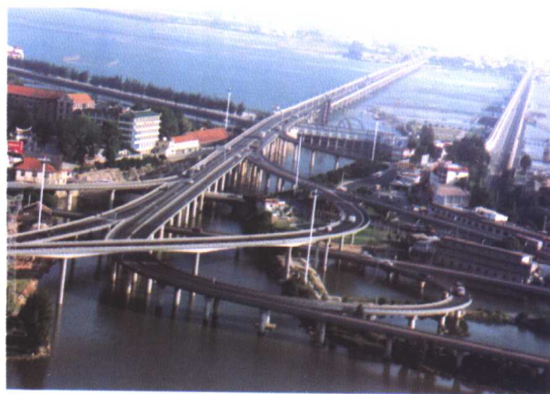
泉厦高速公路集美连接线立交桥
