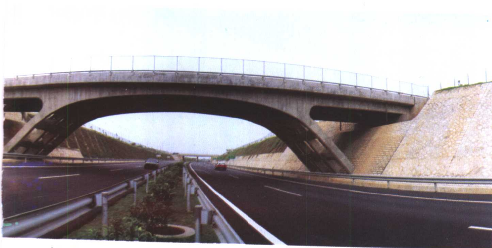
斜腿钢构跨线桥
