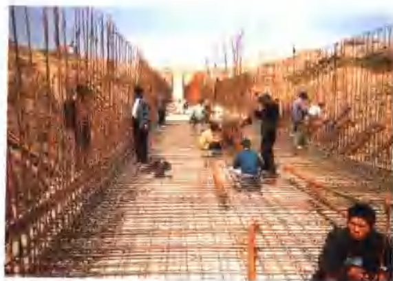
▲ 繁忙的水利工程施工工地
