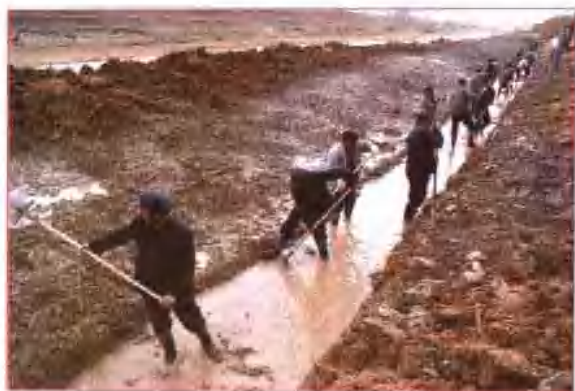
▲ 漯河市对沙河、澧河险工进行施工 (赵红光 摄)
