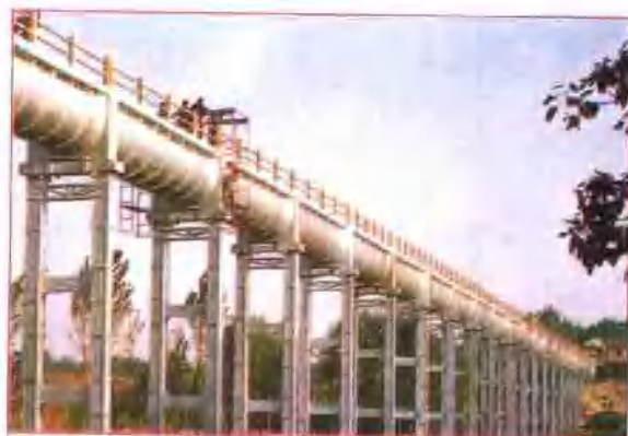
▲ 用整体镇护技术加固修复的郑州市引黄供水咽喉工程——索须河渡槽
