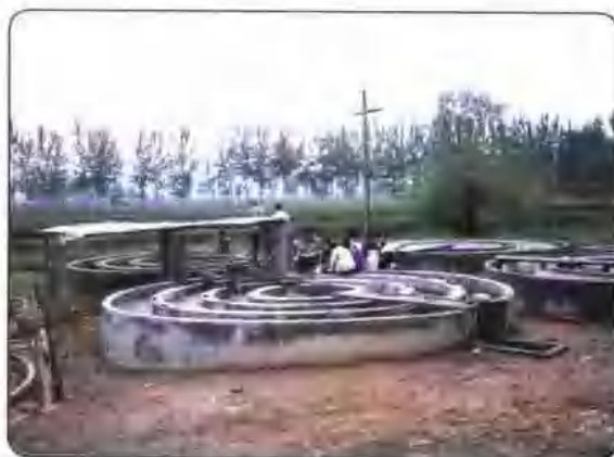
▶ 新投产的双立面全交换家鱼孵化环道 (叶新太 摄)
