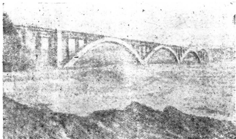
图4-1-4 跨越爱朗河三跨上承式拱桥
