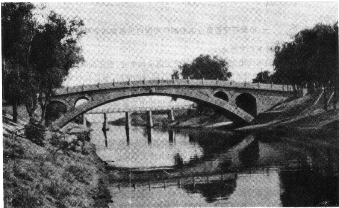
图 1-1-1 河北赵县赵州桥(公元605年)
