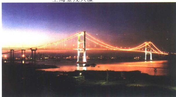
汕头海湾大桥
