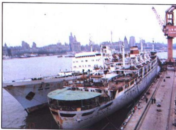
正在修理的大型客輪。
