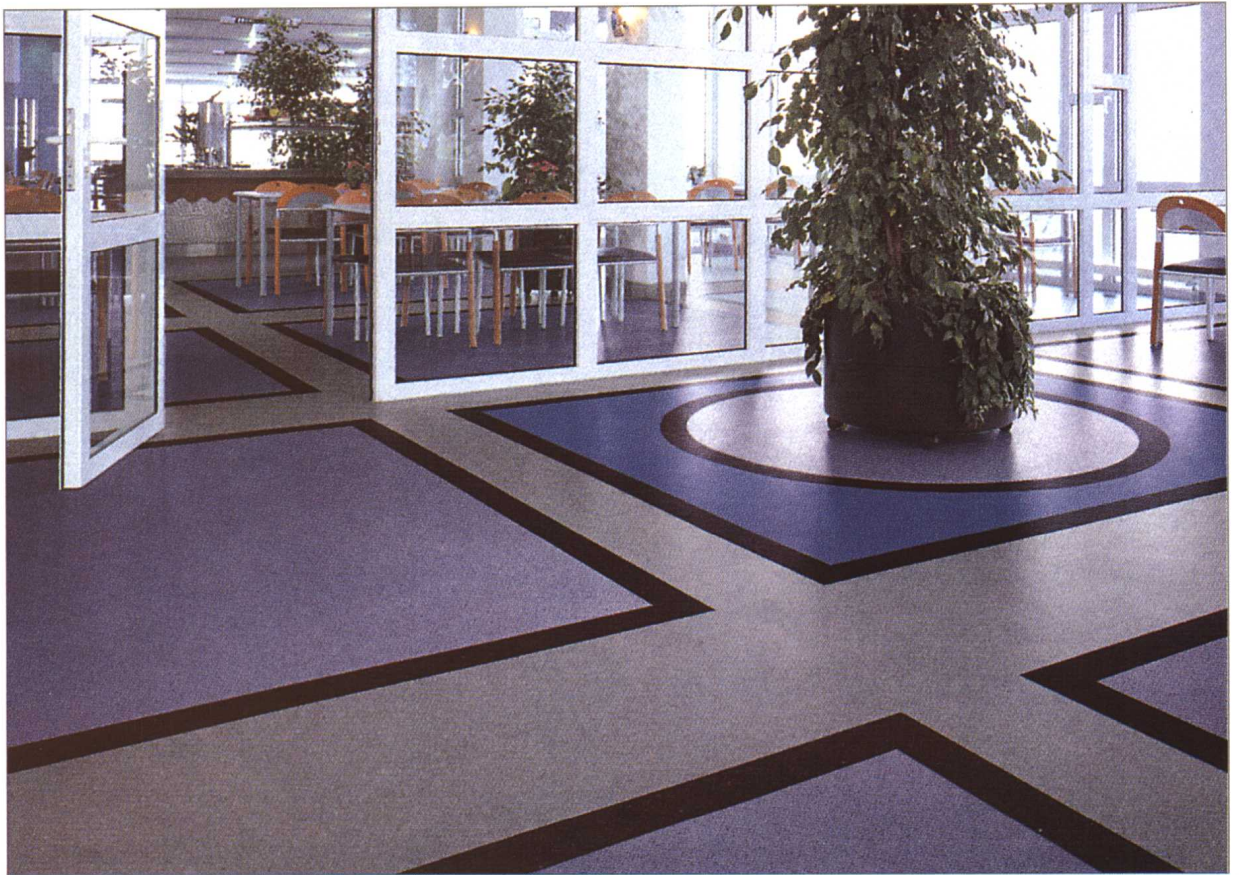
▲ 橡胶地板铺设在门厅地坪(图23)
