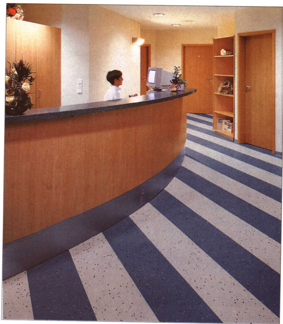
▲ 橡胶地板蓝白相间铺设在接待室门厅(图21)
