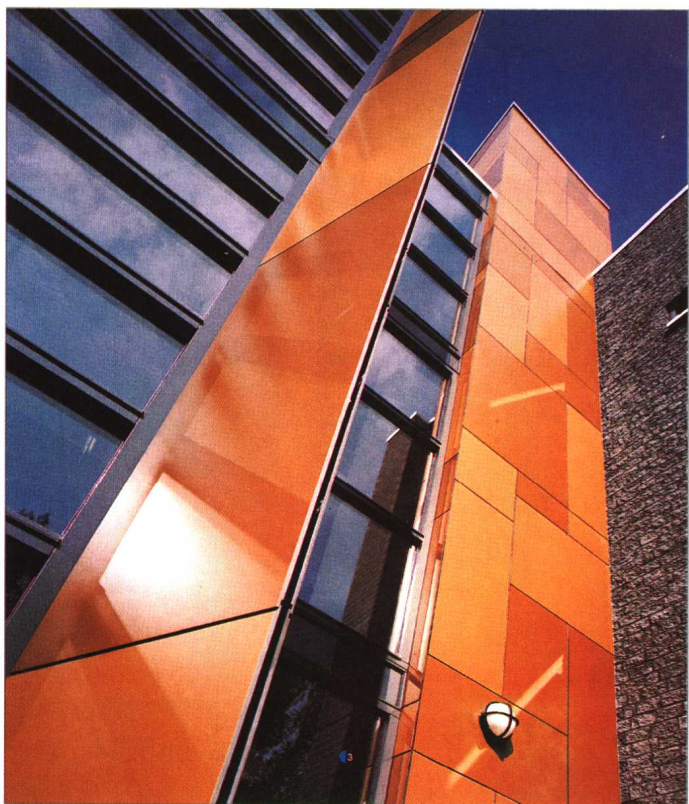
▲ 千思板在建筑物外墙面的应用(图12)
