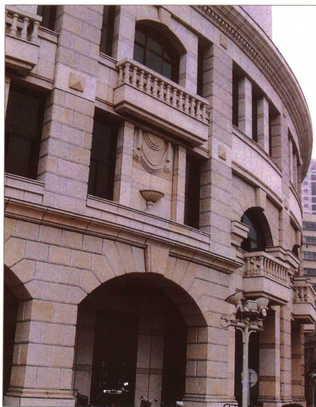
▲ 花岗岩在建筑物外墙面的应用(图1)
