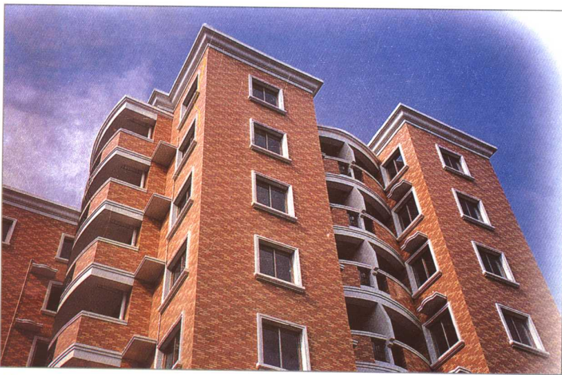
▲ 釉面外墙砖在建筑外墙面的应用(图7)
