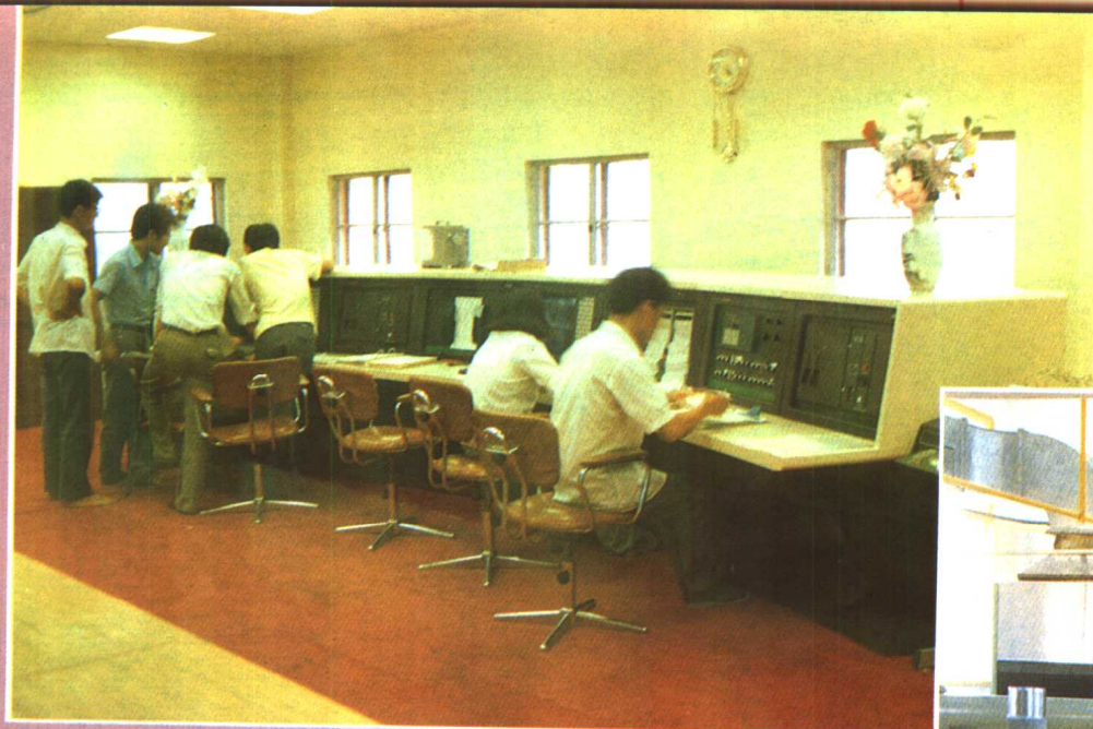
廈門利恒滌綸有限公司成套 引進具有八十年代初國際先進裝 置，年產聚脂切片2萬噸。圖為 中央控制室。
