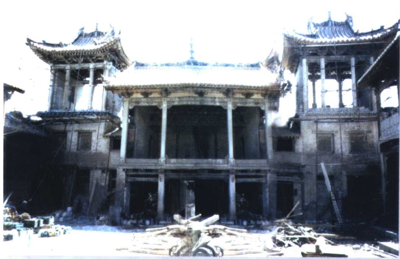
正在维修中的泽州辛壁成汤庙乐楼 （见樊淑敏文）
