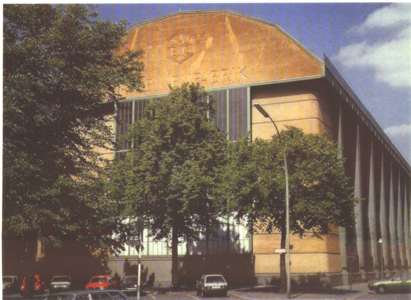
图1-5 德国通用电气公司的涡轮机车间，柏林
