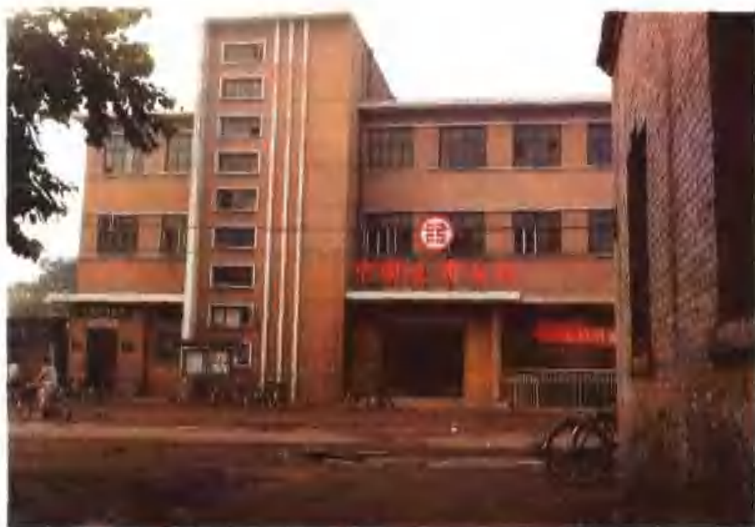
石家庄分行矿区办事处（石家庄市井陘矿区矿市镇）
